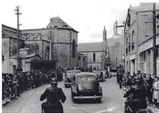
31 mai 1948 : le Président de la République Vincent Auriol visite Saint-Pierre. Depuis la rue de la Mairie (aujourd'hui Victor Eusen), on voit les dégâts causés par les bombardements.
